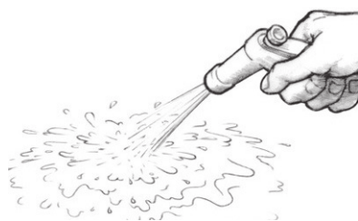
Figure 33 Rincez la surface à l'eau claire après ponçage.
