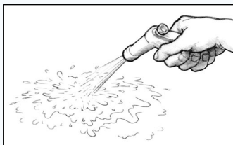
Slika 33 Oprati površinu vodom posle brušenja.
